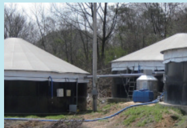
분뇨 탱크 fecal storage tank 분뇨 탱크를 조작합니다. Operate a fecal storage tank.
